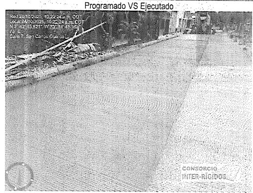
Registro fotográfico avance de obra
